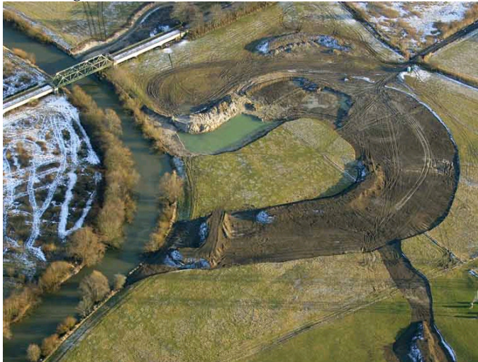
Die neue Lippeschleife soll im Juli 2009 fertig gestellt sein
