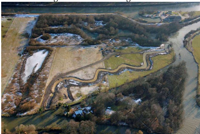
Das Umgehungsgerinne im Bereich des Lippewehres Hamm-Heessen
