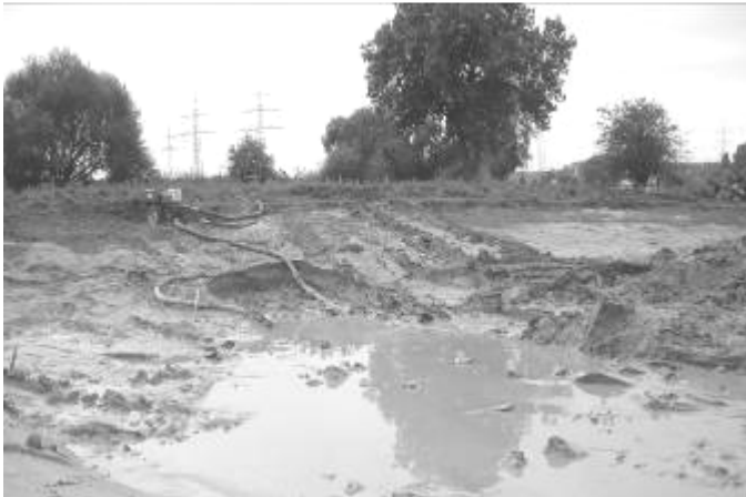
Einströmendes Grundwasser wird während der Bauzeit abgepumpt
