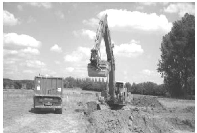
Beginn der Aushubarbeiten
