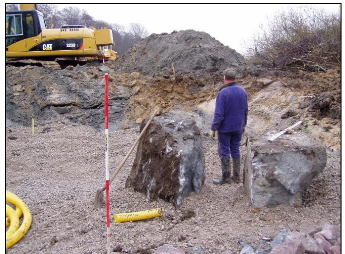
Arbeiten an der Mündung in die Lippe. Gewaltige Wasserbausteine werden eingebracht. (Foto: Stadt Hamm)
