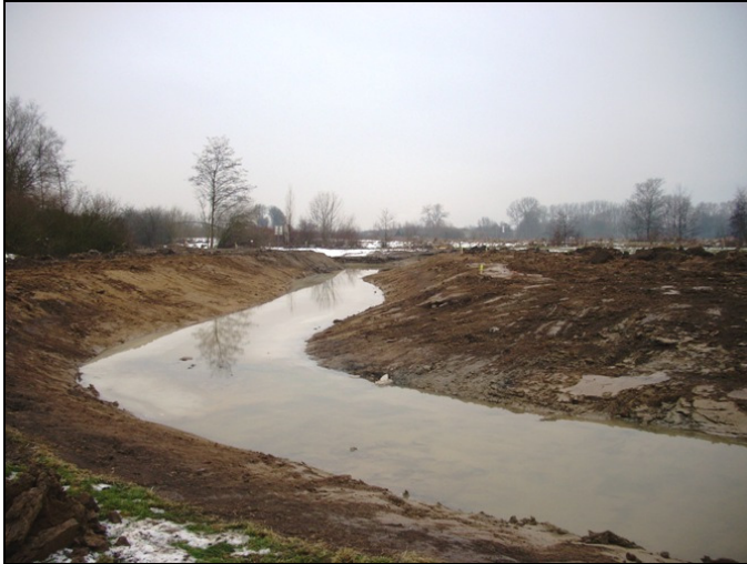
Das naturnah gestaltete Umgehungsgerinne im Bau (13.01.2009) (Foto: Stadt Hamm)
